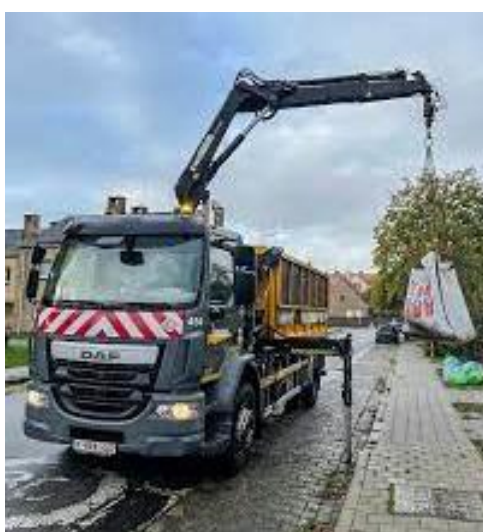
Foto 2: inzameling asbest via een kraanwagen
