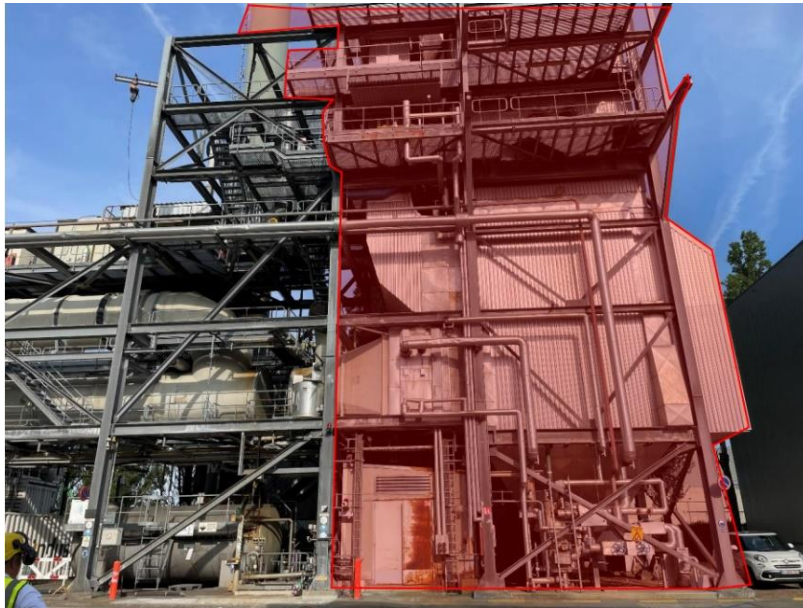
Foto 7: verwijderde denox-installatie in rood
