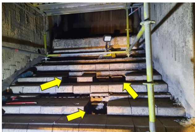
Foto 5: schade aan het verbrandingsrooster veroorzaakt door explosies
