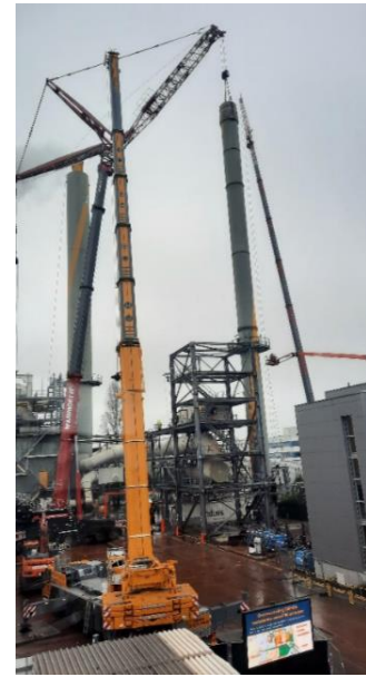
Foto 8: demontage van de schouw
