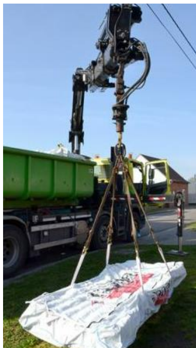
Figuur 8: asbestophaling aan huis.
